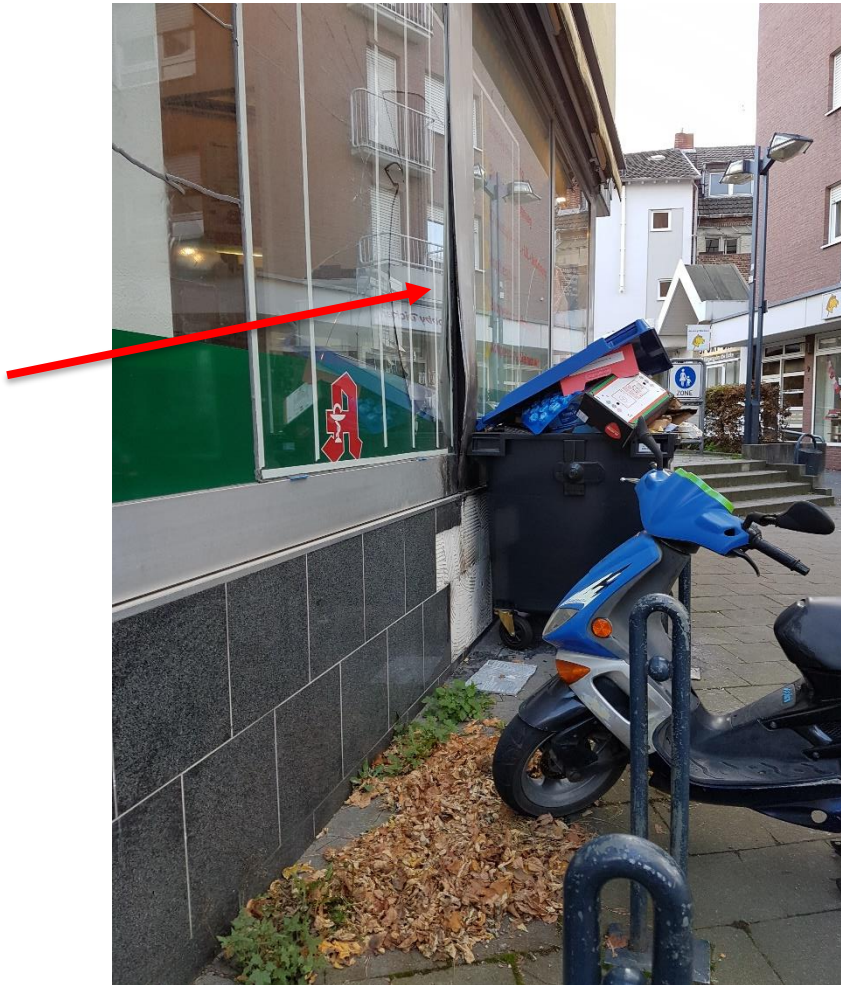
Fassadenschaden durch Brand in einem Müllgefäß
